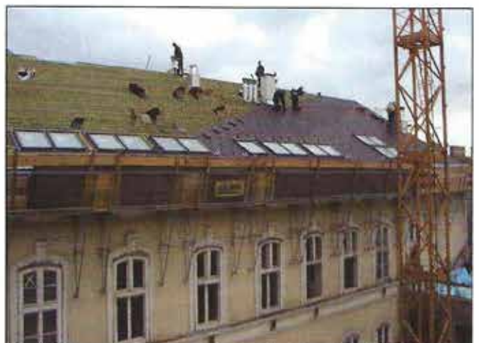
Nach Fertigstellung des Dachausbaues wird das Dach des Realgymnasiums neu eingedeckt
