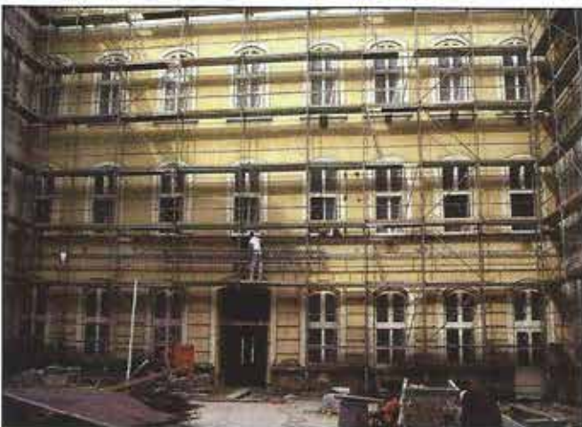
Der neue Innenhof
