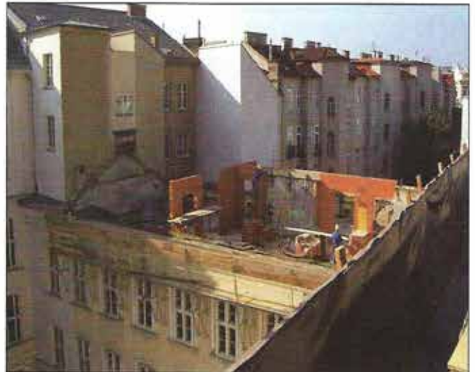
Dachgeschossausbau über dem ehemaligen Physiksaal
